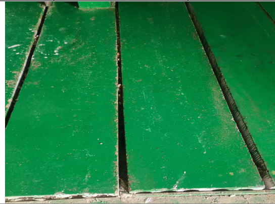
现有工程车间应急池
